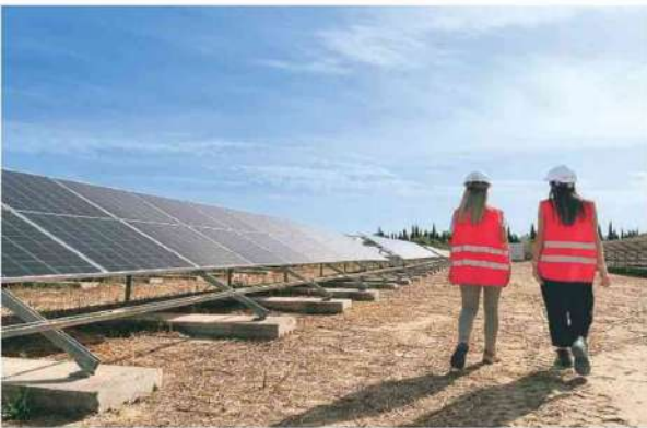
Placas fotovoltaicas de Veolia en Cádiz
